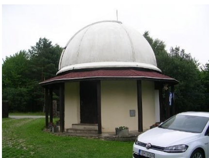
Kopule místní čtyřicetimetrového reflektoru.
