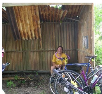
Zbořený Karlásek v příznačné zastávce.
