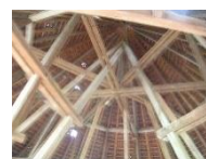
Takto vypadá pořádný krov. Chtěl bych vidět stavební výkresy 😊.
