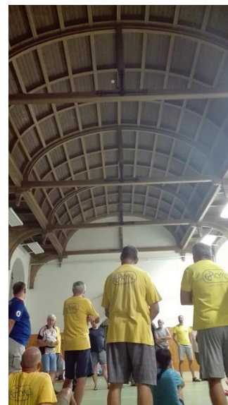
Jihlava se německy řekne Iglau. O historicky silném německém vlivu v tomto městě svědčí i konstrukce střechy tělocvičny.
