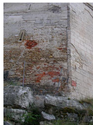
Pod spadnou omítkou je však vidět překvapivá skutečnost, že historické zdivo není provázané! Honem pryč!!!
