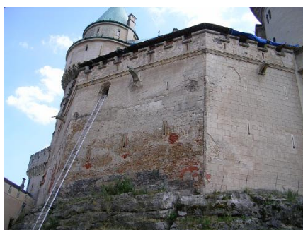
Pod spadnou omítkou je však vidět překvapivá skutečnost, že historické zdivo není provázané! Honem pryč!!!
