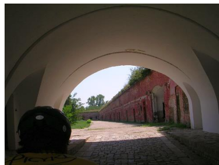
Průjezd je opraven, ale většina pevnosti ještě ne.
