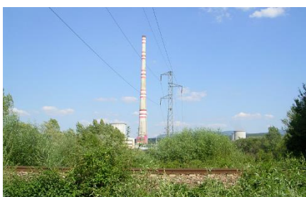
300 m vysoký komín elektrárny v Novákoch. 3. nejvyšší stavba na Slovensku.
