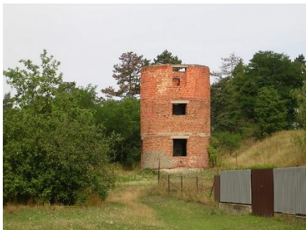
Tato věž je nikdy nedostavěná hvězdárna z 80. let. Třebíč je tedy jedinečné město se dvěma hvězdárnami.
